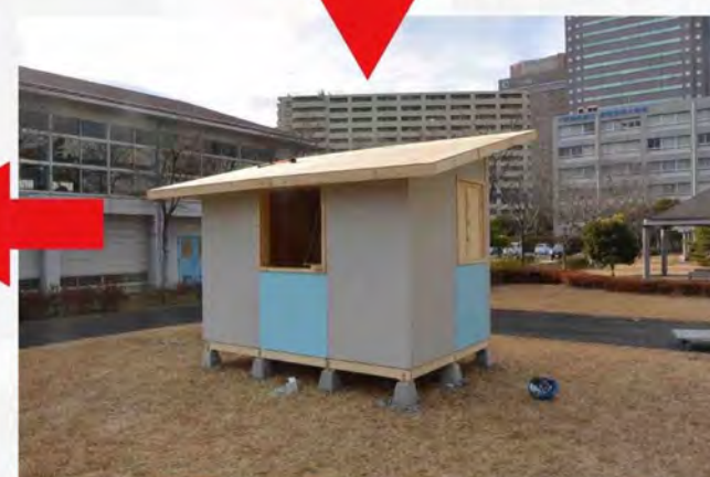
屋根の取り付け
