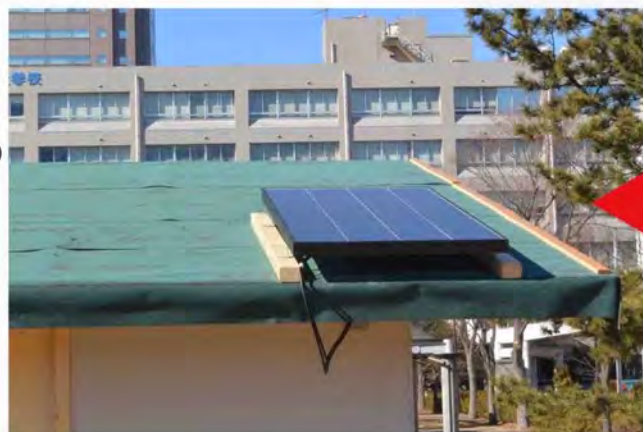
設備の取り付け
