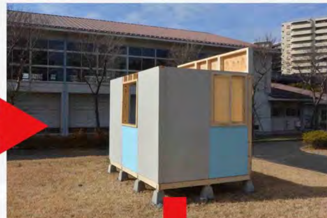
壁の組み立て
